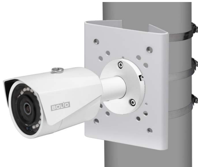
Рисунок 5.12 — Монтаж видеокамеры на столбовом кронштейне BR-103
